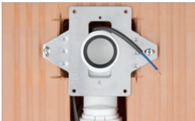
Рис. 5-3 Смонтированная монтажная рамка
